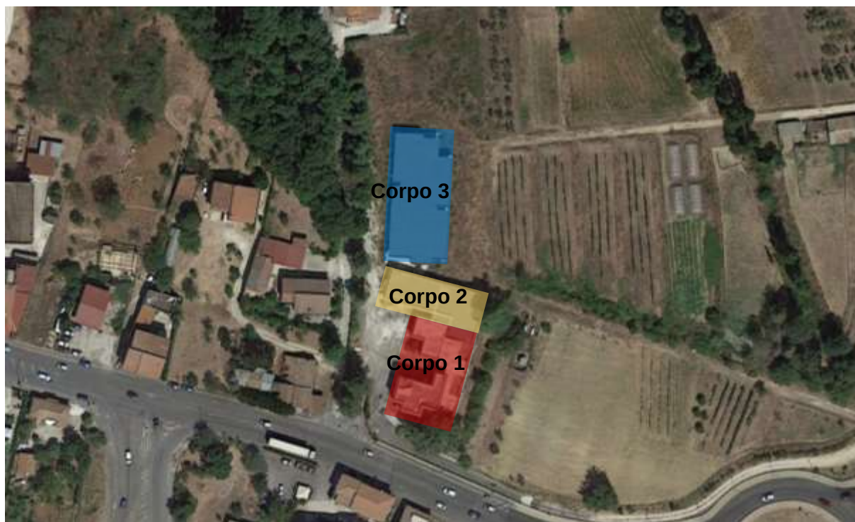
Foto aerea prima della demolizione del corpo 1
