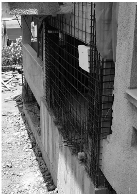
Disposizione armatura parete ex-novo
