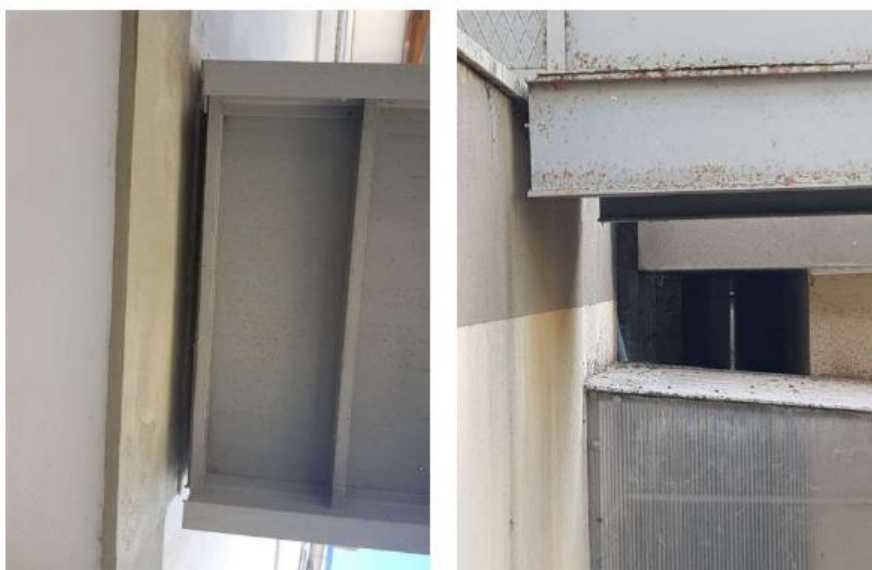
Figura–Particolare del giunto tra la scala esterna in acciaio e il fabbricato
