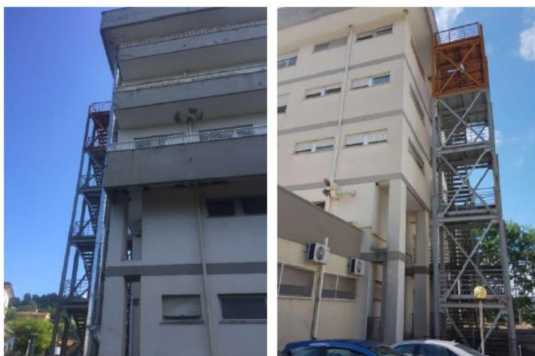
Figura–Vista della scala esterna in acciaio
