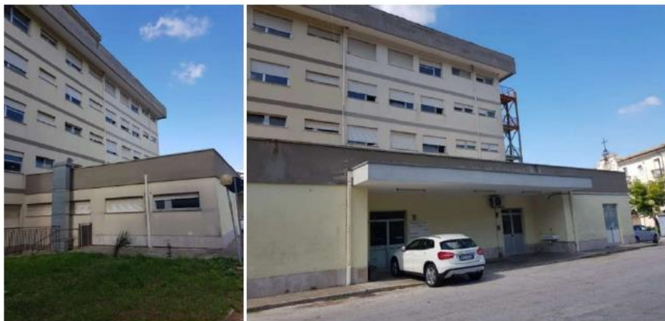
Figura–Vista della pozione di fabbricato che caratterizza la pianta dell’edificio nei primi due livelli determinandone la forte irregolarità planimetrica
