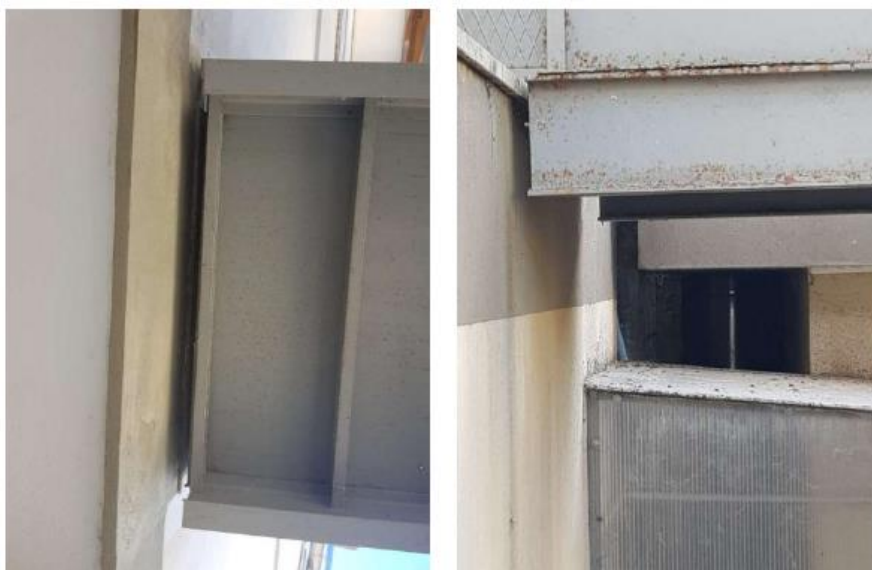
Particolare del giunto tra la scala esterna in acciaio e il fabbricato
