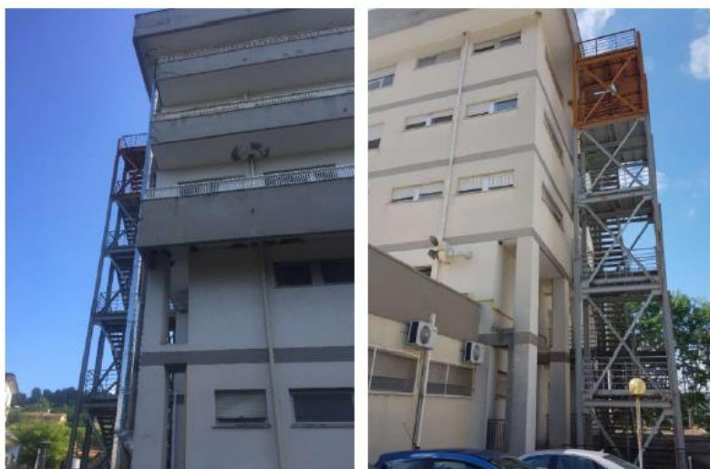
Figura–Vista della scala esterna in acciaio
