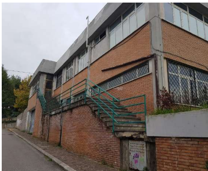
Foto 11 – scala esterna prospetto est
